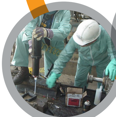
Shimsning av Fundament
