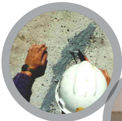
Reparation av Sprickor
