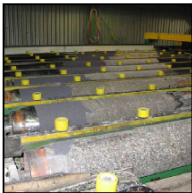
Tidigare beläggning med Belzona® som nu ska utökas till ett större antal rullar.
