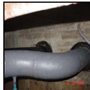
Slutförd beläggning
