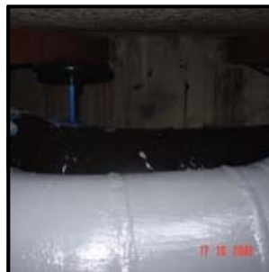
Slutförd beläggning med Belzona® 5851 (Framledning) Belzona® 5841 (Returledning)
