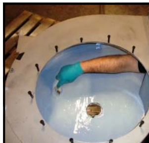
Fläkthus under beläggning med Belzona ® 1341.
