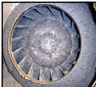
Latexrester som påverkar fläktens kapacitet avsevärt.
