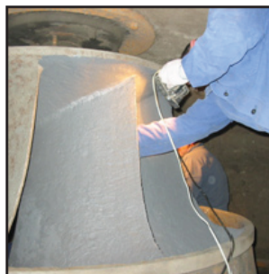
Återuppbyggnad med Belzona® 1111
