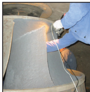
Återuppbyggnad med Belzona® 1111
