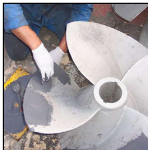
Reparation av impeller med Belzona® 1311
