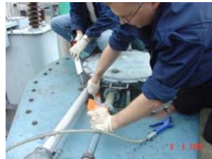
Injecering av Belzona® 1831 i spalten ovanför packning.
