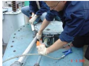
Injecering av Belzona® 1831 i spalten ovanför packning.
