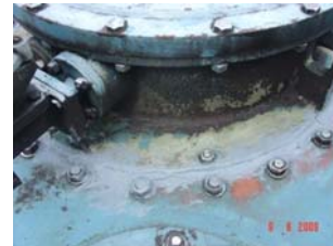
Spalten fylld med Belzona® 1831.
