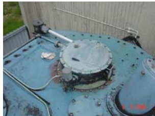
Läckage från lindning- kopplarens packning.
