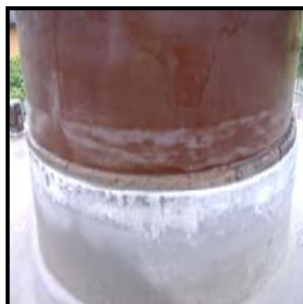
Läckande transformatorbussning
