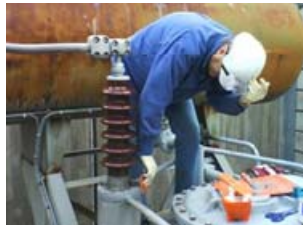
Tätning av genomföring med Belzona® 1831.
