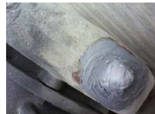
Läckande oljeplugg som åtgärdats med Belzona® 1831.
