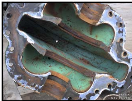
Pumpen invändigt innan arbetet påbörjats.
