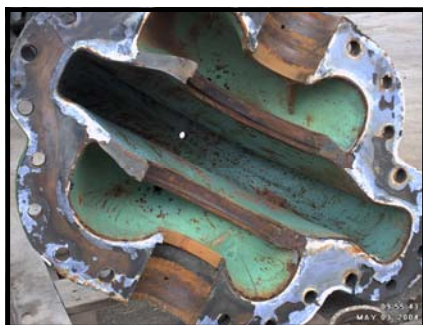
Pumpen invändigt innan arbetet påbörjats.
