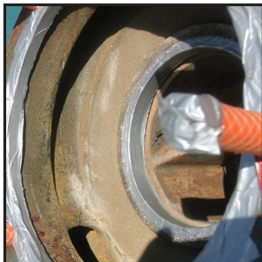
Uppgradering av pump påbörjad
