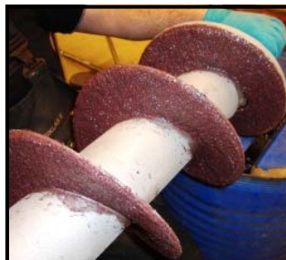
Beläggning påbörjad med Belzona® 1811.
