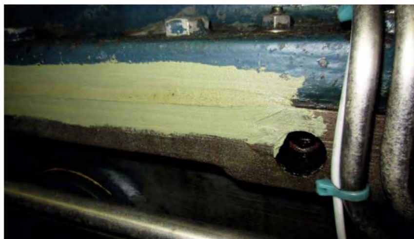
Ett försök pågår där man utvärderar hur metoden och materialen fungerar när man inte har möjligheten att utföra ett optimalt underarbete.
