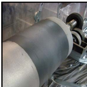
Vals reparerad och klar att sprutbeläggas med Belzona® 1341.
