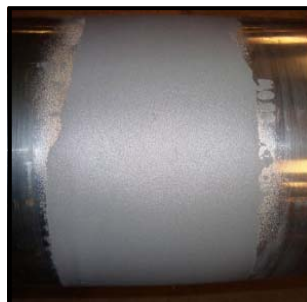
Skadorna på valsen lagas upp med Belzona® 1111.
